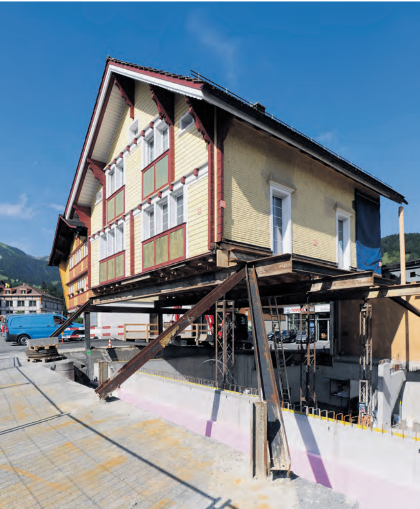
«Haus auf Stelzen», damit das vergrösserte Keller- sowie Erdgeschoss realisiert werden konnten.
